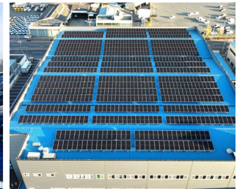
구조물 및 모듈 설치
